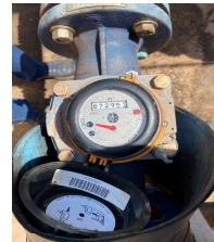
Figura 12 - Macromedidor, destacando-se o totalizador de volumes
