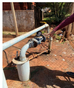
Figura 1 – Afioramento do poço
