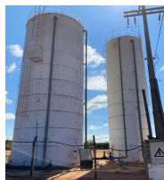
Figura 23 – Vista Geral R1 e R2
