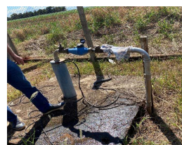
Figura 25 - Vista Geral do Poço P04
