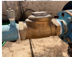
Figura 11 - Válvula de retenção no cavalete
