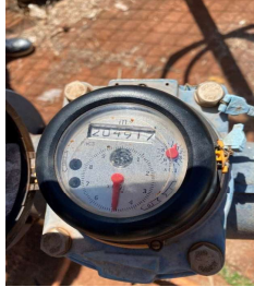
Figura 5 - Destaca-se o macromedidor com totalizador de volumes captados.
