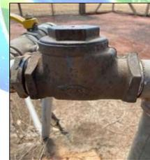
Figura 30 – Válvula de retenção.
