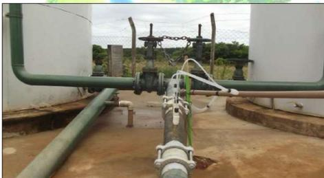
Figura 39 – Tratamento da água com cloro e flúor na entrada dos reservatórios
