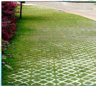
Figura 74 – Exemplo de aplicação de pavimento poroso (Concregrama)
