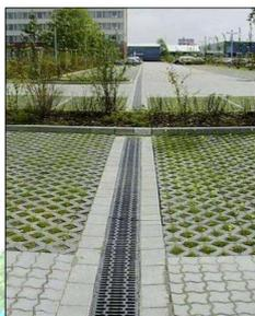
Figura 75 – Aplicação de trincheira de infiltração em passeios
