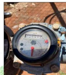
Figura 17 - Destaca-se o macromedidor com totalizador de volumes captados.
