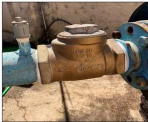
Figura 23 – Válvula de retenção no cavalete.
