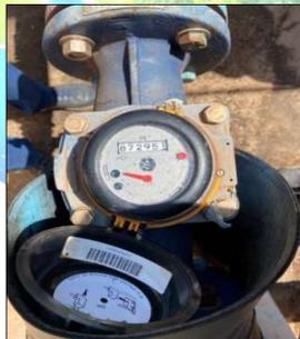
Figura 24 – Macromedidor, destacando-se o totalizador de volumes.
