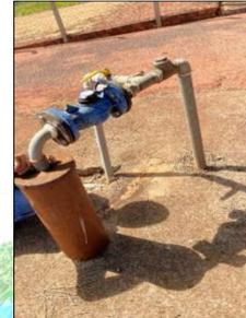
Figura 29 – Dispositivos, tubo de medição de nível, laje de proteção sanitária.
