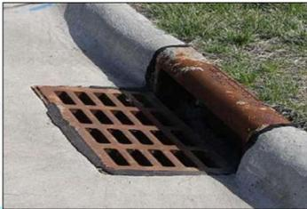
Figura 72 – Gradeamento em boca de lobo na sarjeta
