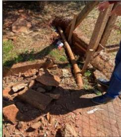
Figura 19 - Tubulação de PVC - PBA DN 80 mm (rede elevatória).
