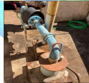
Figura 22 – Dispositivos; Tubo medidor de nível, laje de proteção sanitária.
