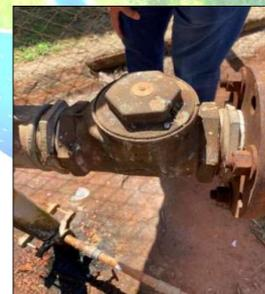
Figura 18 - Válvula de retenção no cavalete de recalque.
