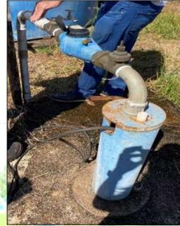
Figura 36 – Dispositivo: Laje de proteção sanitária e tubo medidor de nível.
