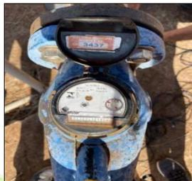
Figura 31 – Medidor destacando-se o totalizador de volumes captados.
