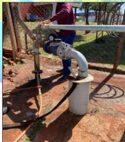
Figura 16 - Dispositivos: laje de proteção sanitária e tubo para medição de nível.
