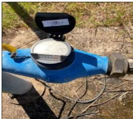
Figura 38 – Vista do macromedidor de vazão dos volumes captados.
