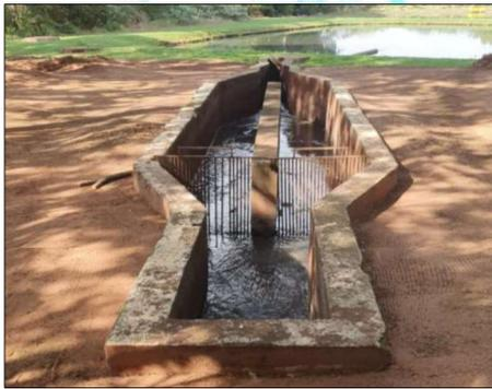
Figura 47 – Sistema de Gradeamento, Desarenador e Calha Parshall
